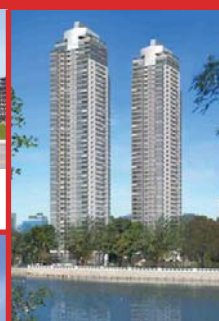
Torre Le Parc
