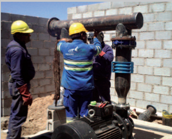
Montaje equipos en estación de bombeo
